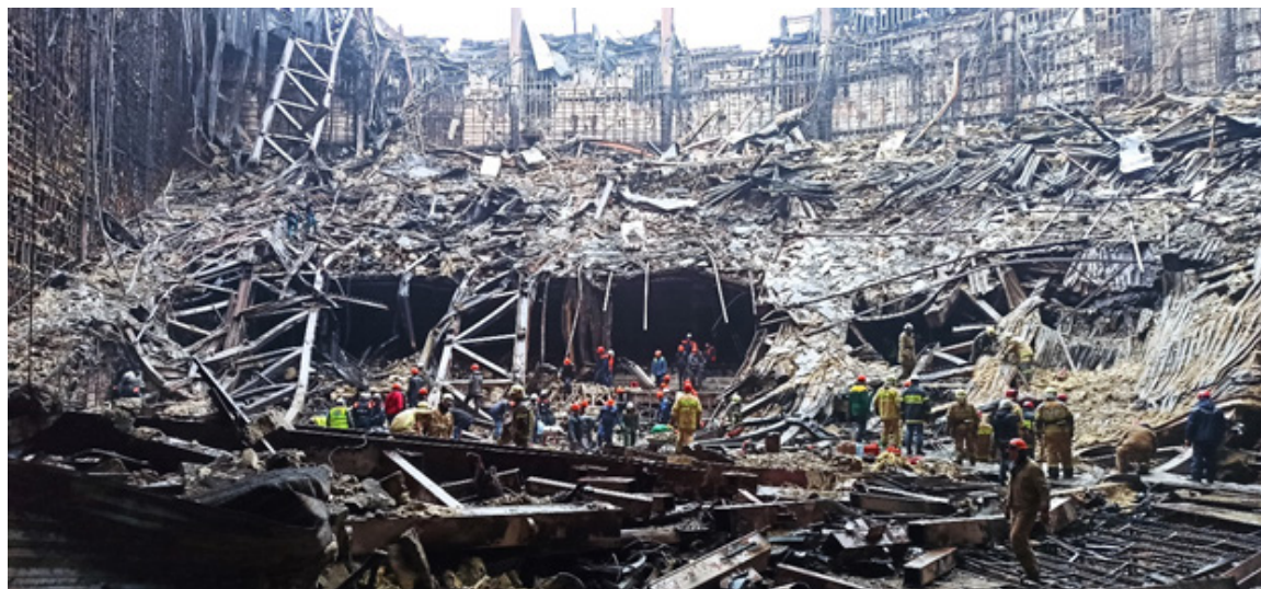
Рисунок 2 – Условия проведения работ на площадке КЗ Крокус Сити Холл
