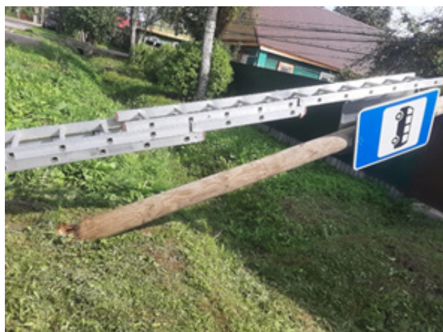
Рисунок 2 – Результат падения опоры воздушной линии связи под действием веса работника и приставной лестницы
