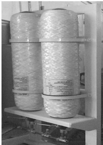
Рисунок 3 – Блок баллонов комбинированных универсальных БКУ-40-350С. ТУ 2296-030-18074387-2006
