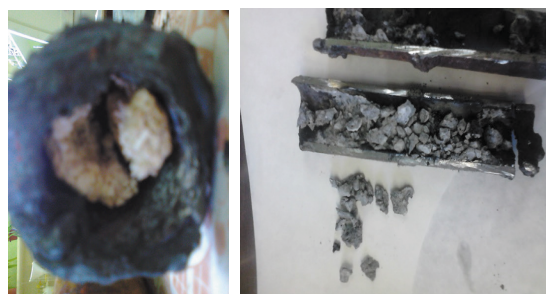
Рисунок 2 – Отложения на внутренних поверхностях нагрева тепломеханического оборудования
