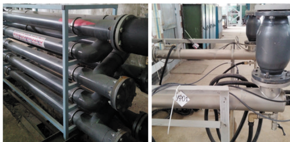
Рисунок 6 – Общий вид части смонтированного оборудования по изменённой технологии подготовки воды для подпитки тепловой сети для коагулирования / флокуляции (слева) и для обеззараживания (справа)
