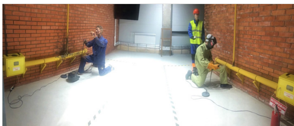
Рисунок 1 – МИО «Сварочные работы»
