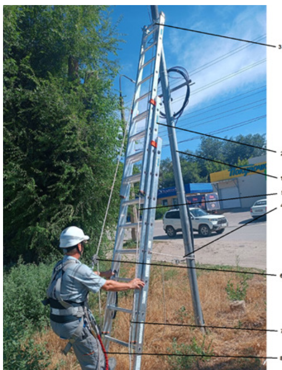
Рисунок 1 – Общий вид системы спасения и эвакуации, интегрированный со страховочной системой при работе на опоре с лестницы
