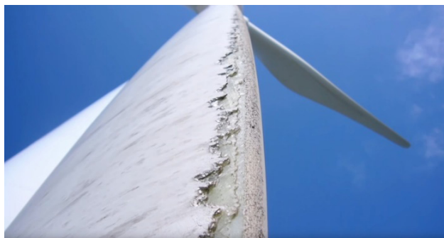
Рисунок 7 – Эрозия лопастей ветротурбин
