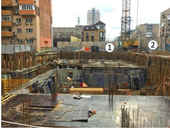
Рисунок 2 – Место проведение натурных исследований: 1, 2 – места нанесения раствора
