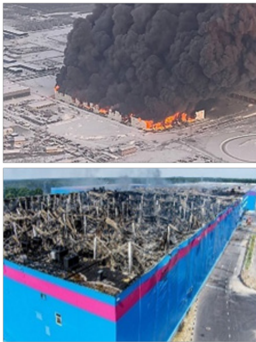
Рисунок 3 – Пожары и их последствия на складах со стеллажным хранением ТМЦ
