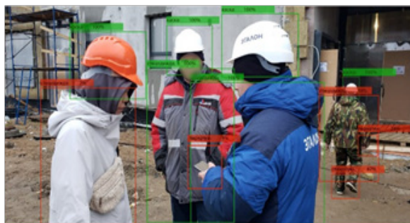
Рисунок 5 – Пример регистрации нарушений по критерию «СИЗ» смарт-видеокамерой на участке строительной площадки ЖК «Пулковский дом»
